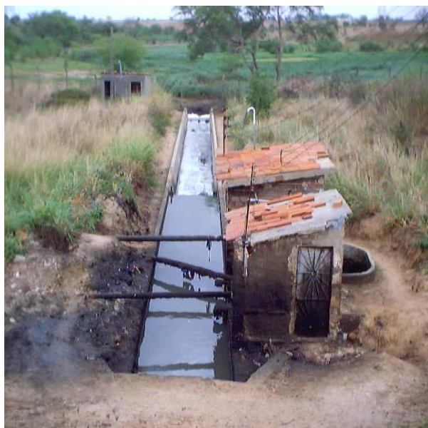
Figura 3.a – Captação na saída da estação
