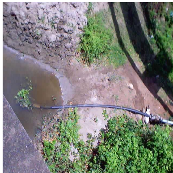
Figura 3.b – Captação após lançamento
