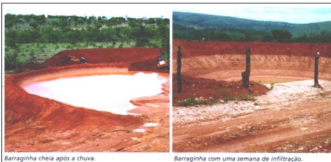
FIGURA 5 – Fotografias de barraginha cheia após a chuva (lado esquerdo) e após uma semana de infiltração (lado direito) (Barros, 2000).
