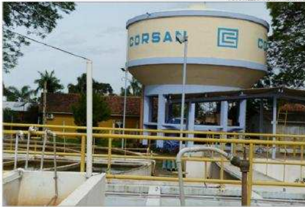
Estação de tratamento de água no bairro Rodrigues
